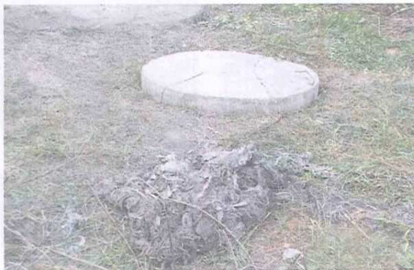
Z komór kanalizacyjnych na granicy sieci często muszą być usuwane różne niedozwolone elementy stałe
